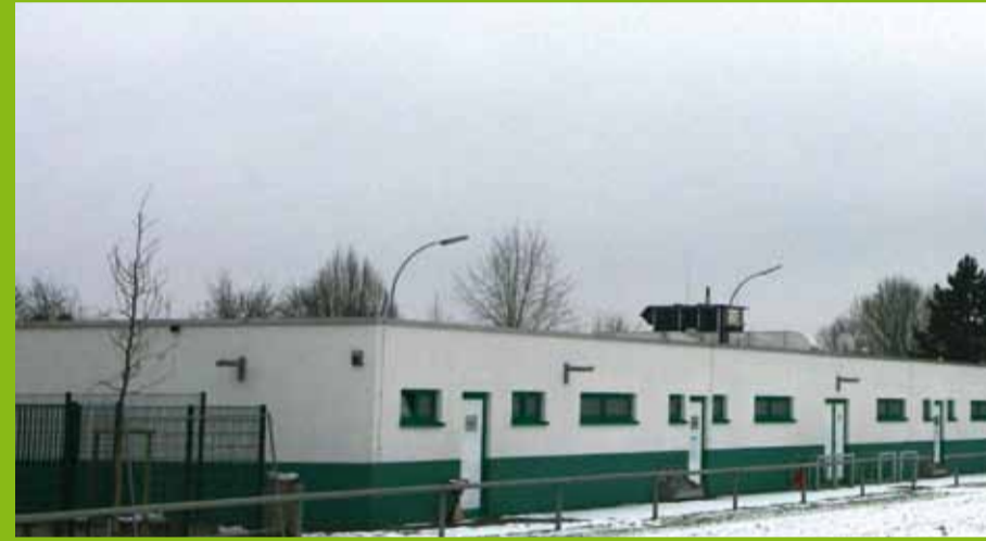
Vestiaires a Luuchten Eileréng Terrain de football d'Ehlerange : vestiaires et éclairage
