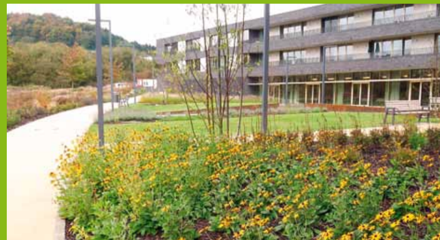
CIPA „résidence Waassertap“ CIPA « Résidence op der Waassertap »
