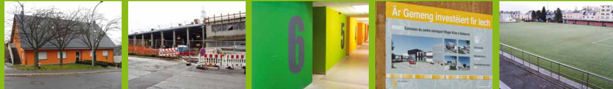
Die Gemeinde finanzierte einen großen Teil des Scoutgebäudes Luss Collini in Sanem. Das neue moderne Gebäude für unsere Rettungsdienste ist momentan im Bau. Die vorbildliche Arbeit unserer Freiwilligen wird durch das zentrale Gebäude sicherlich erleichtert. Nachdem ein Teil des Sportkomplexes auf Scheuerhof bereits erneuert wurde, ..... wird momentan weiter ausgebaut. Ein neues größeres Lehrschwimmbecken, eine Anlage für den Beleser Turnverein und ein neuer Kulturaal sind momentan im Bau. Der Beleser Fußballverein erhielt ein synthetisches Spielfeld und komplett neue Umkleekabinen.
