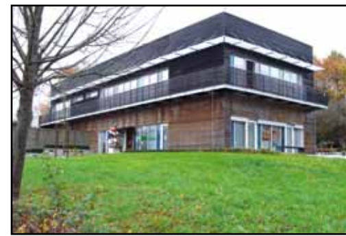
Das zentrale neugebaute Maison Relais Gebäude steht in Zolwer. Hier werden etwa 80 Kinder das ganze Jahr über von qualifiziertem und motiviertem Personal betreut. Somit wird Familien- und Berufsleben besser vereinbar.
