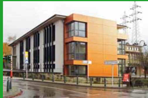
Zurzeit wird die Schule Chemin-Rouge neu gestaltet.
