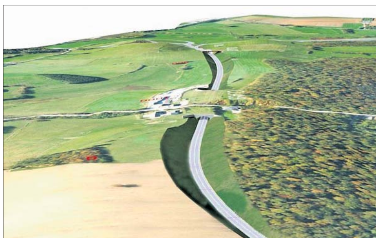
Die zweispurige Umgehungsstraße könnte tiefer gelegt werden (hier auf Sassenheimer Seite), so dass sie von den Wohnsiedlungen aus nicht sichtbar wäre.
