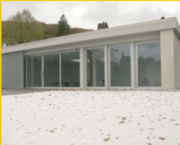
In Zolver wurde die "Morgue" komplett renoviert und zeigt sich nun wieder den ersten Anlässen würdig.
